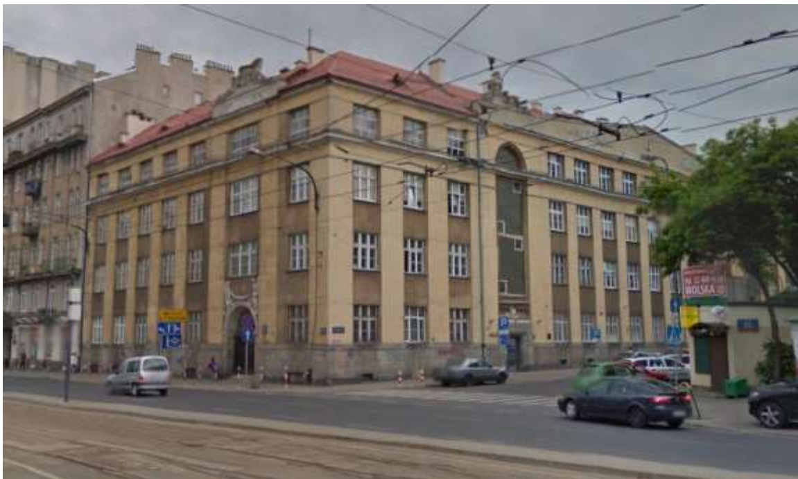
Budynek dawnego Szpitala Dziecięcego w Warszawie przy ul. Działdowskiej 1.
